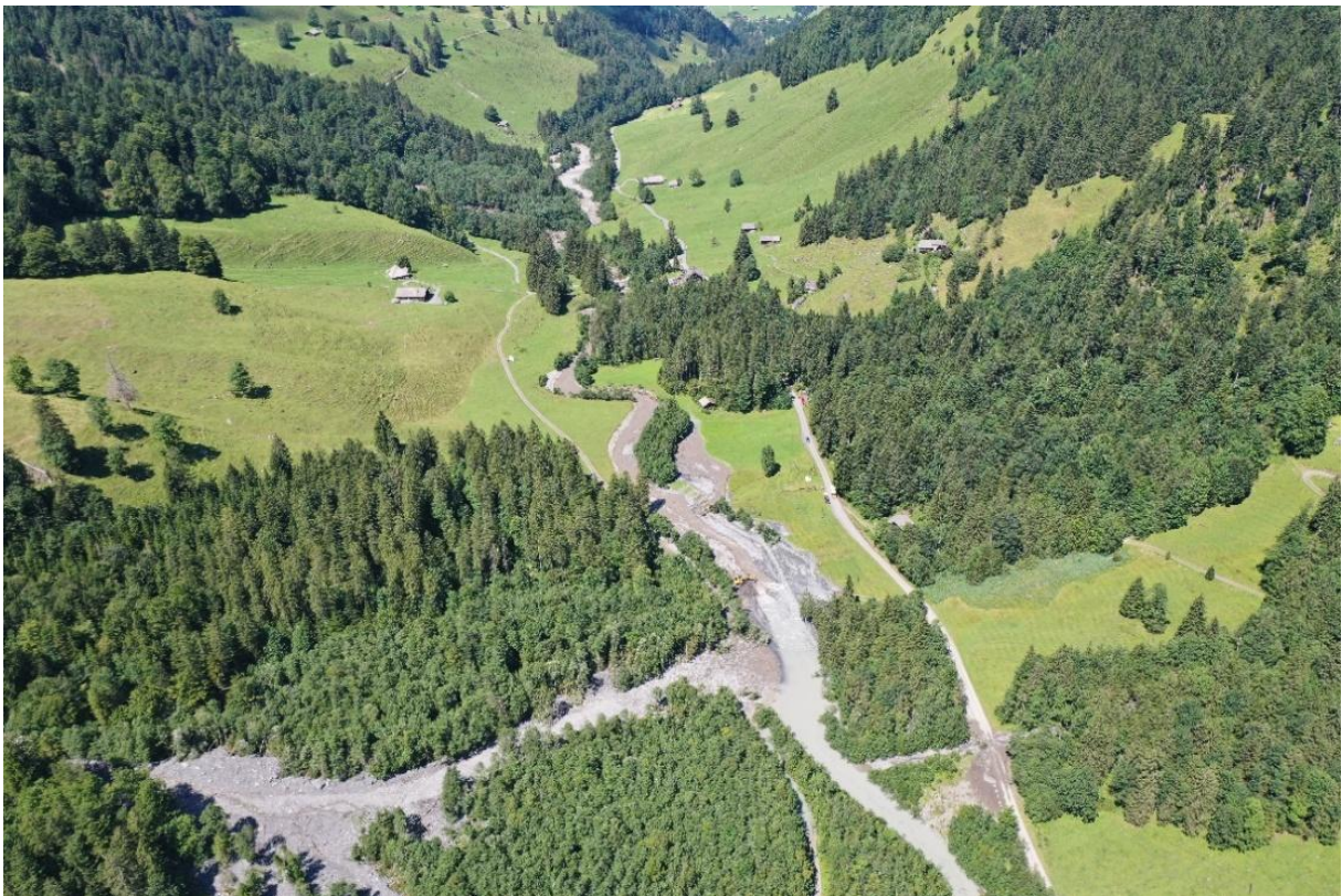
Abbildung 1: Situation im August 2024. Baggerarbeiten für die Absenkung der Gewässersohle.
