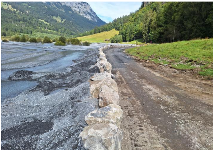
Ausführung Strassenanhebung, 12. September 2023
