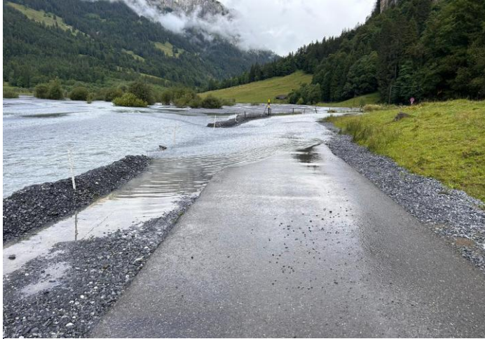
Überschwemmung Strasse, 11. August 2023
