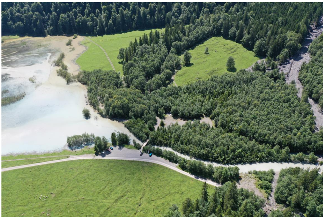
Rückstauung aufgrund des Ereignisses vom 12. August 2024 (Kellerhals + Haefeli AG)
